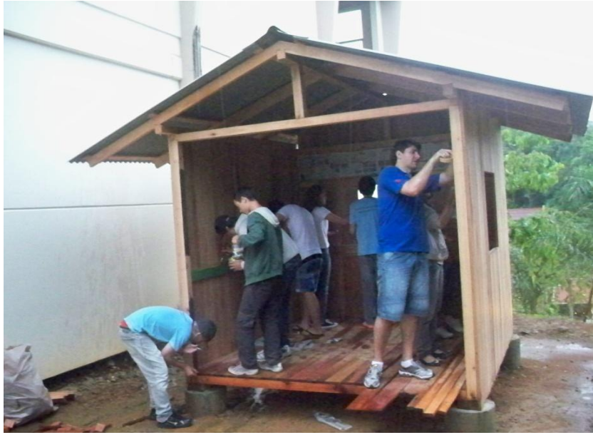
Figura 1 - Estudantes realizando a pintura da casa
