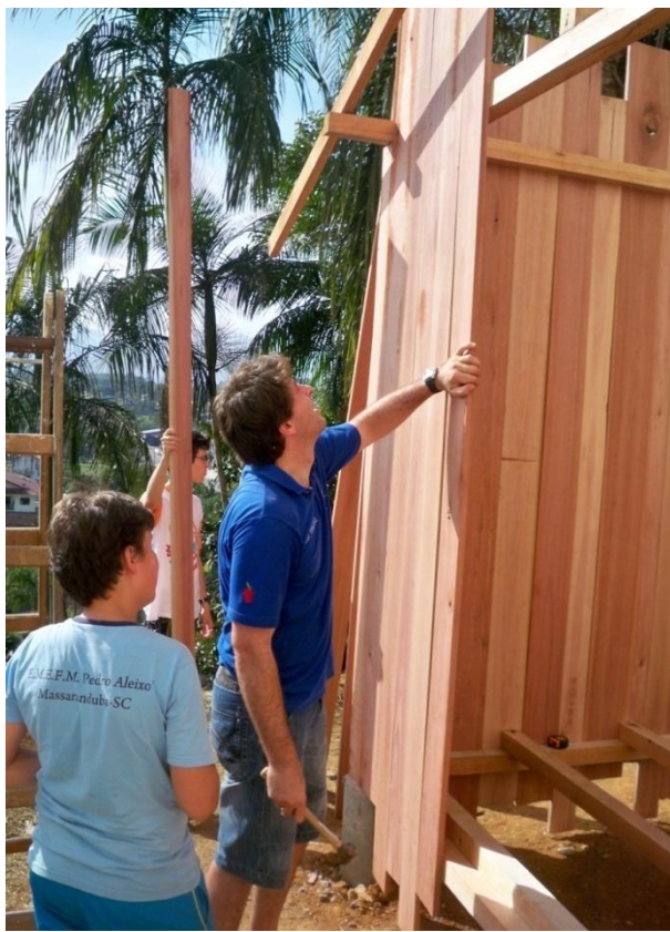
Figura 1 - Estudantes auxiliando na construção da casa
