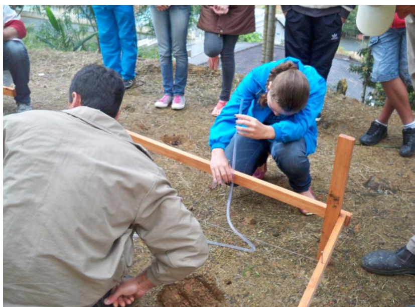
Figura 2 - Estudantes realizando o nivelamento do terreno
